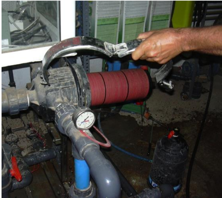
Filtro en la impulsión de un sistema fijo de pulverización neumática en perfecto estado de limpieza y sin deterioro
