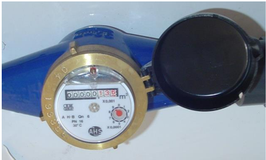
Caudalímetro mecánico y cuadro de gestión y control instalado en una instalación fija de pulverización neumática
