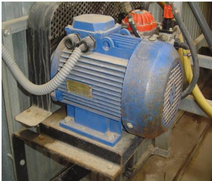
Equipo sin señales de humedad, sin fugas ni goteo por ninguna junta de la bomba
