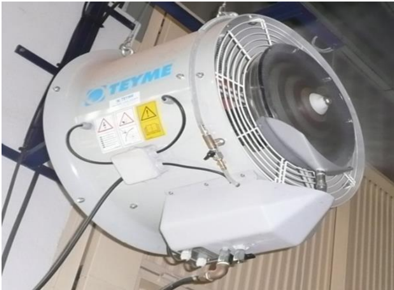
Detalle de pulverizador centrífugo con asistencia de aire (hidroneumático)
