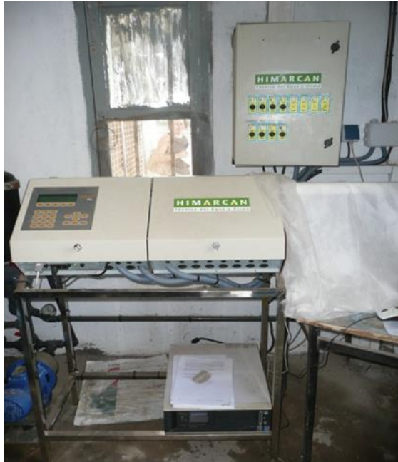
Mandos electrónicos centralizados de una instalación de nebulización, accesibles y operativos para su manejo
