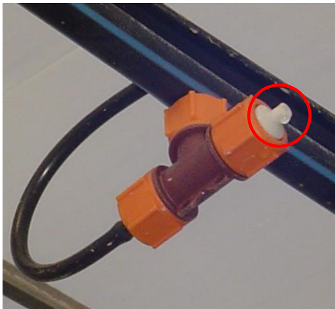
Boquilla donde se observa que transcurridos 5 segundos sigue goteando
