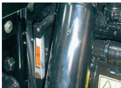
Ventana para controlar el nivel de aceite del sistema hidráulico.
