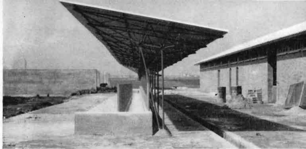
Fig. 13.—En esta estabulación libre, en construcción, se aprecia el canal para el emparrillado de la zona de alimentación.
