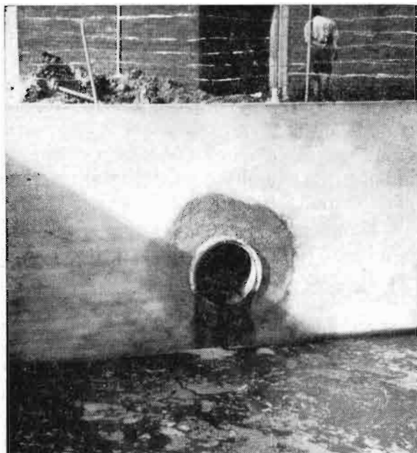
Fig. 4.—Las deyecciones, mezcladas con agua, se recogen en una fosa. Esta que aquí vemos es descubierta y va protegida por una alambrada.
